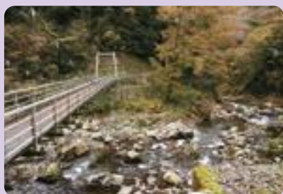
シヨムレ橋 地域を結ぶ橋
